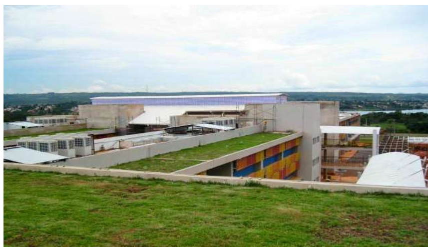
Figura 27: Telhado verde do Instituto Federal de Brasília (IEF)
