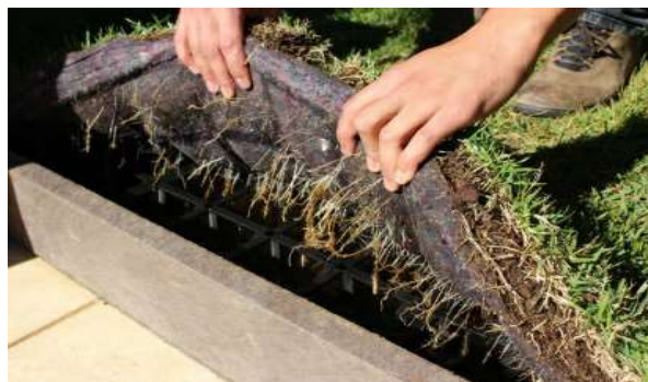
Figura 17: Montagem do telhado verde
