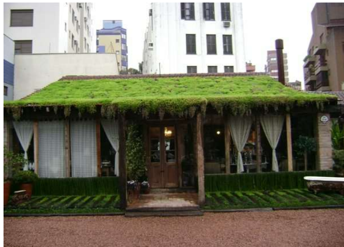
Figura 23: Telhado verde- Grama Amendoim
