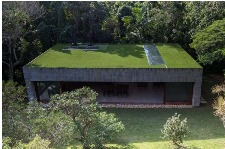
Figura 24: Telhado verde não convencional
