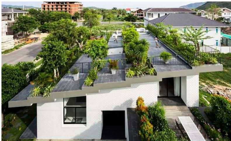
Figura 25: Telhado verde com árvores.
