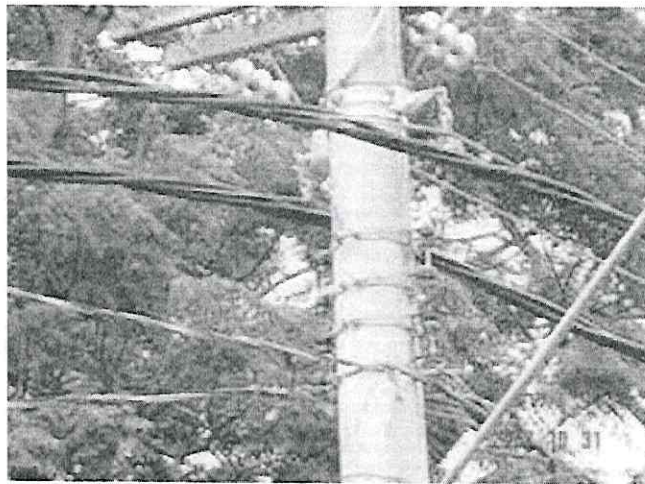
FIGURA 7 - Rede de distribuição aérea isolada
