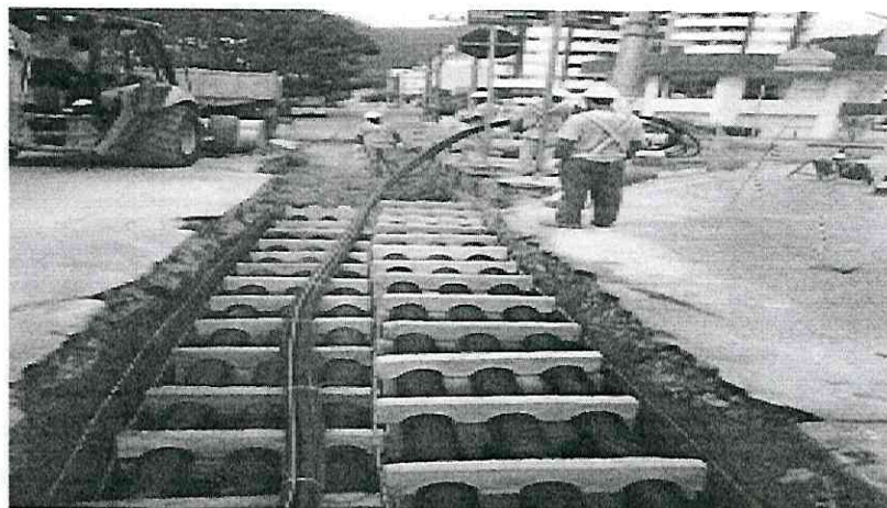
FIGURA 8 - Rede de distribuição subterrânea
