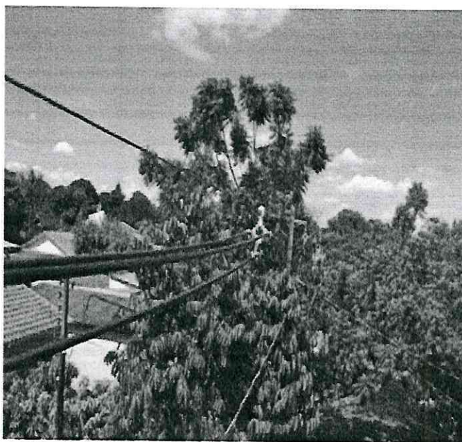
FIGURA 6 - Rede de distribuição aérea compacta
