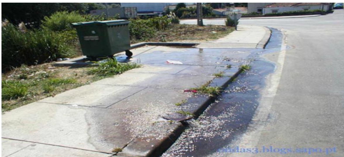
FIGURA 3. Desperdício de água
