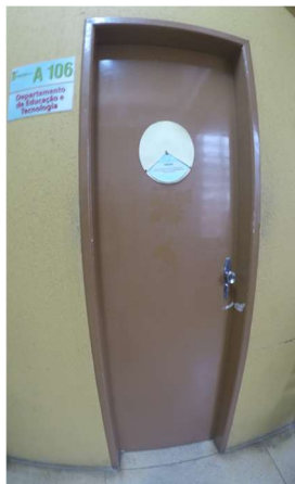
Imagem 45 - Porta Sala A-106 sem sinalização em relevo, não possui maçaneta do tipo alavanca.
