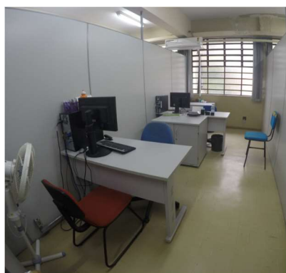
Imagem 22 - Gabinete 04 localizado na sala A-207 com Atendimento ao público sem circulação que permita giro de 180° á P.C.R, e sem mesa acessível facilmente identificada.
