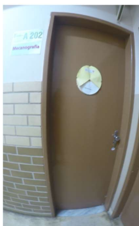
Imagem 35 - Porta sala A-202 sem sinalização em relevo, não possui maçaneta do tipo alavanca.
