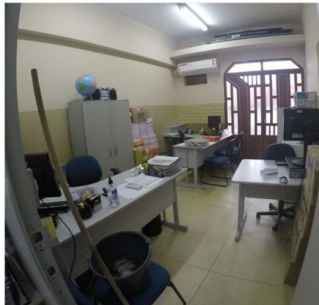
Imagem 51 - Bancada de atendimento da sala de DEC sem afastamento frontal para atendimento de P.C.R, ambiente não possui espaço para manobra de P.C.R.
