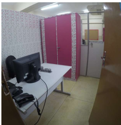
Imagem 53 - Bancada Sala A 105 - de atendimento sem afastamento frontal para atendimento de P.C.R, ambiente não possui espaço para manobra de P.C.R.
