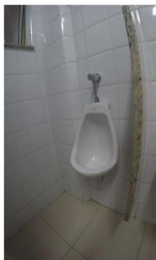
*Imagem 46 – Mictórios existentes no sanitário masculino coletivo do pavimento térreo não possuem barras de apoio, a altura não está de acordo com a mínima estabelecida pela norma.*
