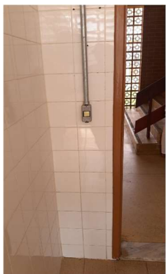
Imagem 69 - Interruptor localizado no sanitário feminino do pavimento térreo está a 110cm do piso e possui altura maior do que a máxima recomendada pela norma.
