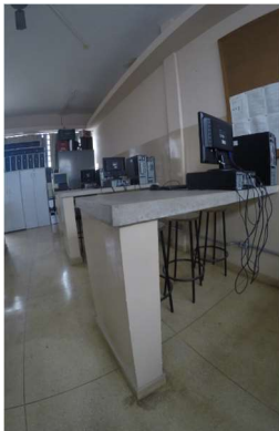
Imagem 35 – Bancadas de trabalho Sala B 201 não possuem a altura máxima permitida pela norma.
