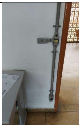
Imagem 51 - Interruptor localizado na sala D-101 a 105 cm do piso e tomara a 30 cm do piso, ambos possuem altura maior e menor, respectivamente, do que a máxima recomendada pela norma.
