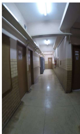
Imagem 9 - Circulação interna do 1º pavimento Bloco D - não possui rota acessível.
