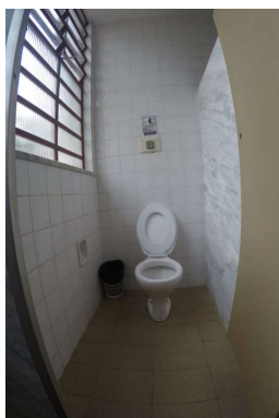
Imagem 47 - Porta do boxe em sanit rio feminino no t rreo abre para dentro sem ter um raio m nimo de circula o dentro dos boxes.
