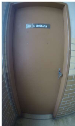
Imagem 18 - Porta Sala D 204 - sem sinalização em relevo e não possui maçaneta do tipo alavanca.
