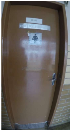
Imagem 46 - Porta Sala 102 sanit rio feminino t rreo sem sinaliza o em relevo.
