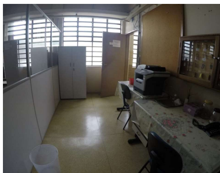
Imagem 23 - Circulação interna sala D 207 possui mobiliários que dificultam a circulação. Portas do ambiente não possuem maçaneta do tipo alavanca e sinalização em relevo.
