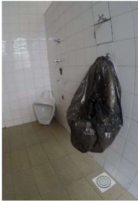
Imagem 45 - Mictório em sanitário Masculino coletivo o t rreo n o est  de acordo com a norma.
