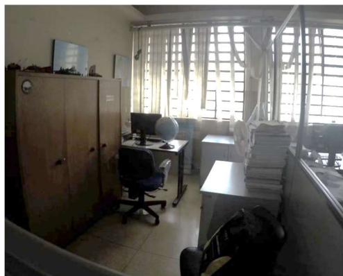
Imagem 28 - Ambiente dentro da Sala D 207 não possui mesa acessível para atendimento ao público, não possui espaço para manobra de P.C.R.
