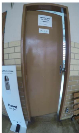
Imagem 17 - Porta D 101 - sem sinalização em relevo e não possui maçaneta do tipo alavanca.
