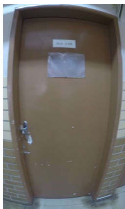
Imagem 15 - Porta D – 105 sem sinalização em relevo e não possui maçaneta do tipo alavanca.
