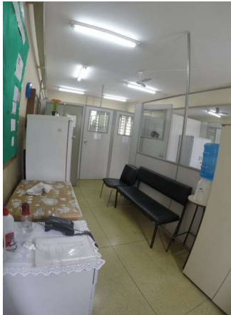
Imagem 18 - Circulação interna Sala E 206 possui mobiliários que dificultam a circulação. Portas do ambiente não possuem maçaneta do tipo alavanca e sinalização em relevo.
