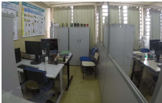
Imagem 22 - Ambiente Sala E 206 não possui mesa acessível para atendimento ao público, não possui espaço para manobra de P.C.R.
