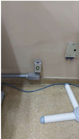
Imagem 103 - Tomada localizada na sala E206, está a 15cm do piso e possui altura menor do que a mínima recomendada pela norma.
