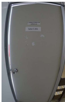
Imagem 26 - Porta Sala E 201 - sem sinalização em relevo e não possui maçaneta do tipo alavanca.
