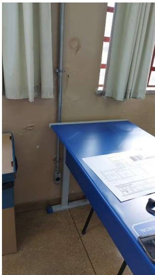
Imagem 109 - Tomada localizada na sala E207, está a 25cm do piso e possui altura menor do que a mínima recomendada pela norma.
