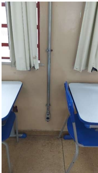
Imagem 107 - Tomada localizada na sala E207, está a 25cm do piso e possui altura menor do que a mínima recomendada pela norma.
