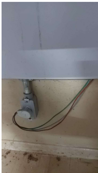
Imagem 73 - Tomada localizada na biblioteca, estão a 25cm do piso e possui altura menor do que a mínima recomendada pela norma
