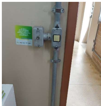
Imagem 71 - Interruptor localizada na biblioteca, está 110cm do piso e possui altura maior do que a máxima recomendada pela norma
