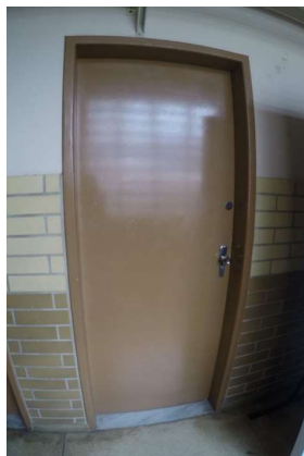
Imagem 46 - Porta sem sinalização em relevo e visual e não possui maçaneta do tipo alavanca.
