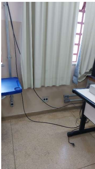
Imagem 88 - Tomadas localizada na sala E204, estão a 19 e 30cm do piso e possui altura menor do que a mínima recomendada pela norma.
