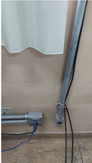
Imagem 91 - Tomadas localizada na sala E205, estão a 25 e 30cm do piso e possui altura menor do que a mínima recomendada pela norma
