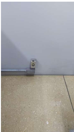
Imagem 95 - Tomada localizada na sala E206, está a 15cm do piso e possui altura menor do que a mínima recomendada pela norma.
