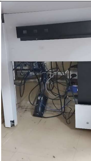
Imagem 66 - Tomadas localizada no acervo biblioteca, estão a 30cm do piso e possui altura menor do que a mínima recomendada pela norma
