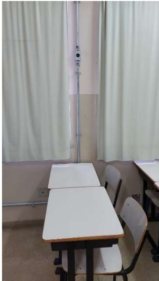
Imagem 86 – Tomada alta localizada no laboratório de línguas sala E201, está a 180cm do piso e possui altura maior do que a máxima recomendada pela norma.
