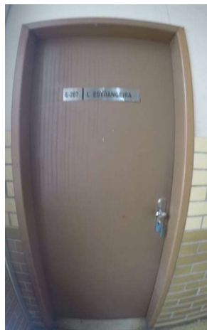
Imagem 25 - Porta Sala E 207 - sem sinalização em relevo e não possui maçaneta do tipo alavanca.
