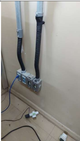
Imagem 70 - Tomadas localizada no acervo biblioteca, estão a 25cm do piso e possui altura menor do que a mínima recomendada pela norma
