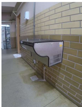
Imagem 7 – Bebedouro térreo apenas com uma altura e sem sinalização tátil de alerta.
