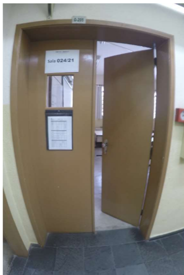
Imagem 25 - Porta sala G 205 - sem sinalização em relevo, não possui maçaneta do tipo alavanca.
