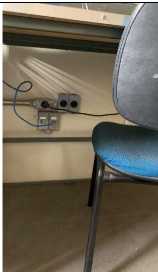
Imagem 72- tomadas localizadas na sala G104 estão a 45cm do piso e possuem altura de acordo com a norma
