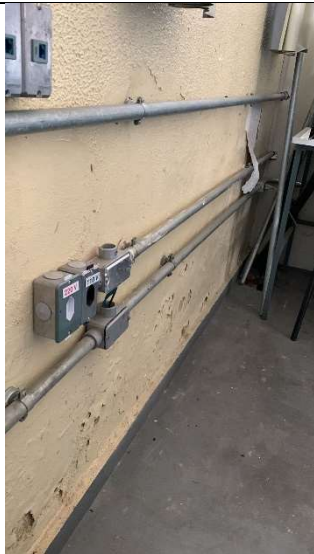
Imagem 71- tomadas localizadas na sala G104 estão a 45cm do piso e possuem altura de acordo com a norma
