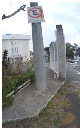
Imagem 8 – Acesso de pedestres ao campus não está sinalizado de forma correta, calçada não possui dimensionamento correto. Poste dificulta a circulação.
