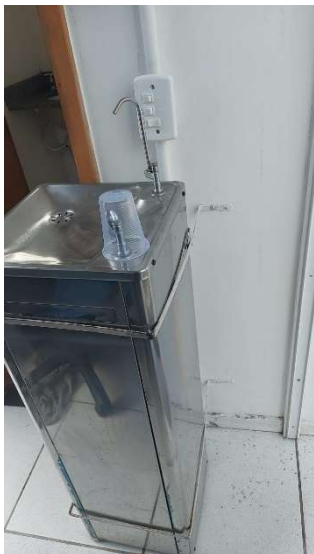
Imagem 15 - Interruptor a 105cm do piso e possui altura maior do que a máxima recomendada pela norma
