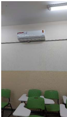
Imagem 79 – Tomada alta localizada na sala H-205 (Topografia) e se encontra a 250cm do piso e possui altura maior do que a recomendada em norma.
