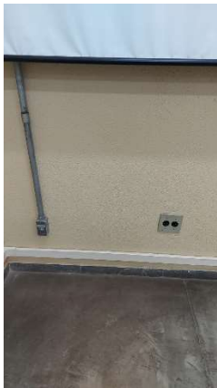
Imagem 65 - Tomada baixa localizada na sala H-201 (LICC) está a 40 cm do piso e possui altura recomendada pela norma
