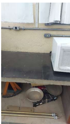
Imagem 50 - Tomadas médias localizadas na sala H-106 estão a 130 e 140 cm do piso e possuem altura maior do que a máxima recomendada pela norma.
