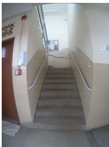
Imagem 51 – Escada Bloco J
