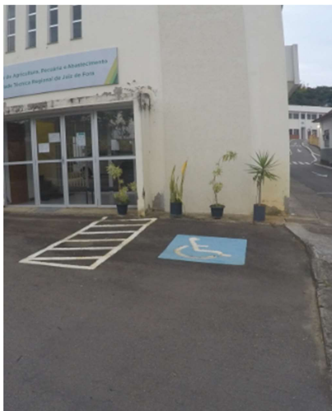
Figura 1 – VAGA DE P.C.R MAIS PROXIMA DA EDIFICAÇÃO, DEVE SER SINLIZADA DE FORMA APROPIADA E LIGADA A UMA ROTA ACESSÍVEL.
