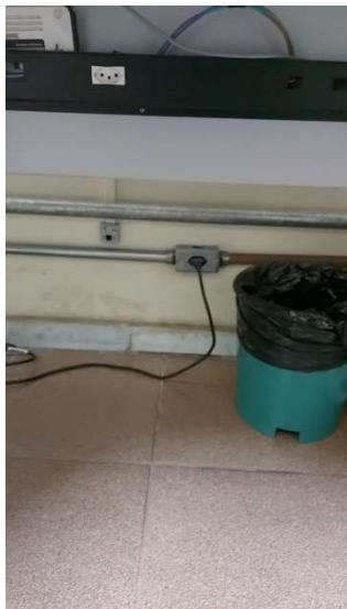
Imagem 37 - Tomada localizada na auditoria, está a 30cm do piso e possui altura menor do que a mínima recomendada pela norma.
