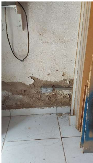
Imagem 85 - Tomada localizada no pet física e estoque, está a 30cm do piso e possui altura menor do que a mínima recomendada pela norma.
