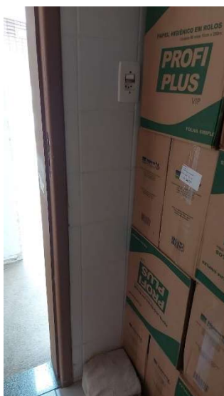
Imagem 86 - interruptor e tomada localizada no pet física e estoque, estão a 120cm do piso e possui altura maior do que a máxima recomendada pela norma.
