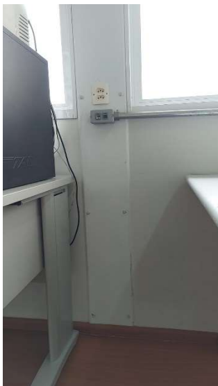
Imagem 5 - Tomadas localizada na sala modular 04 na sala 02, estão com uma altura de 105cm do piso e possui altura maior do que a máxima recomendada pela norma.
