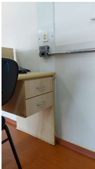
Imagem 7 - Tomadas localizada na sala modular 04 na sala 02, estão com uma altura de 105cm do piso e possui altura maior do que a máxima recomendada pela norma e as outras estão com uma altura de 95 e 90 cm do piso e estão de acordo com a norma.
