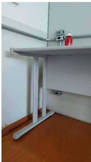
Imagem 8 - Tomadas localizada na sala modular 04 na sala 02, estão com uma altura de 95 e 90cm do piso e estão de acordo com a norma e as tomadas baixa estão com uma altura de 30cm do piso e possui altura menor do que a mínima recomendada pela norma.
