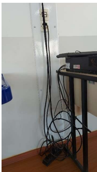
Imagem 3 - Interruptores e tomadas localizada na sala modular 03, os interruptores estão com uma altura de 110cm do piso e possui altura maior do que a máxima recomendada pela norma e as tomadas estão a uma altura de 100cm do piso e sua altura está de acordo com a norma.
