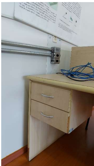
Imagem 6 - Tomadas localizada na sala modular 04 na sala 02, estão com uma altura de 105cm do piso e possui altura maior do que a máxima recomendada pela norma e as outras estão com uma altura de 95 e 90 cm do piso e estão de acordo com a norma.
