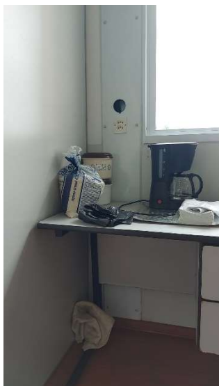
Imagem 4 - Tomadas localizada na sala modular 04 na sala 02, estão com uma altura de 105cm do piso e possui altura maior do que a máxima recomendada pela norma.
