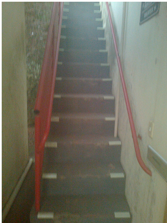
Foto 10 – Escada para sala dos professores no 2º pavimento
