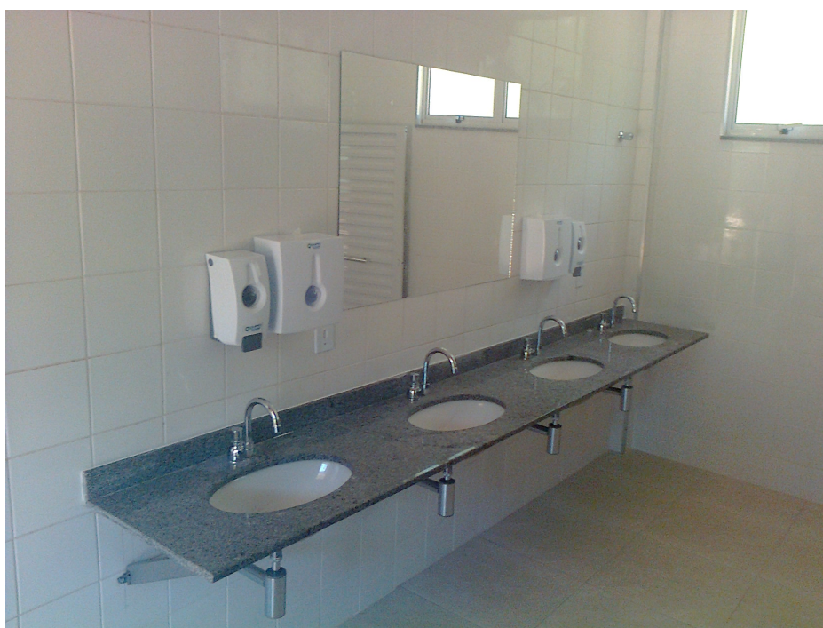
Foto 14 – Bancada do banheiro coletivo masculino
