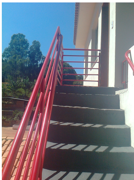
Foto 12 – Acesso ao 3º pavimento
