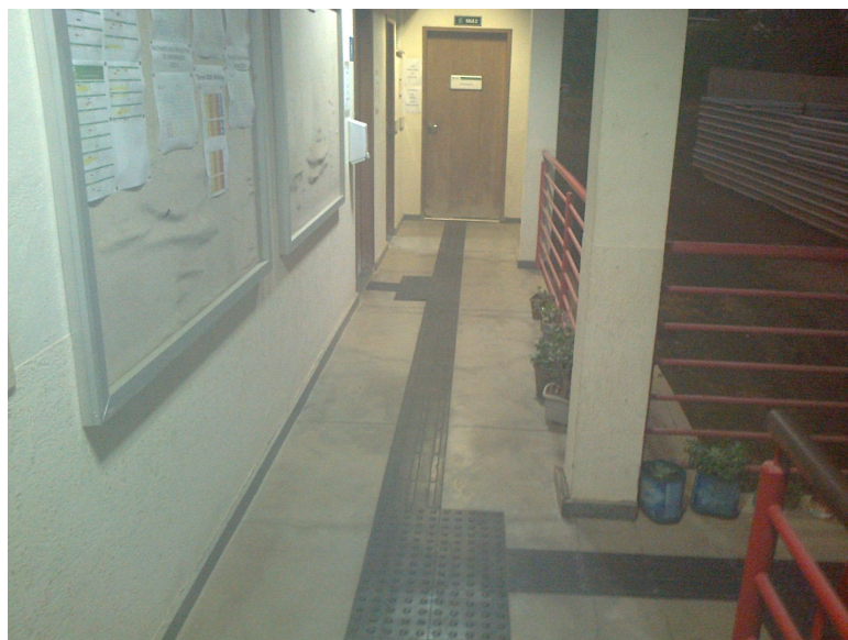
Foto 25 – piso tátil no corredor interno entre copa, banheiros e sala de aula 2
