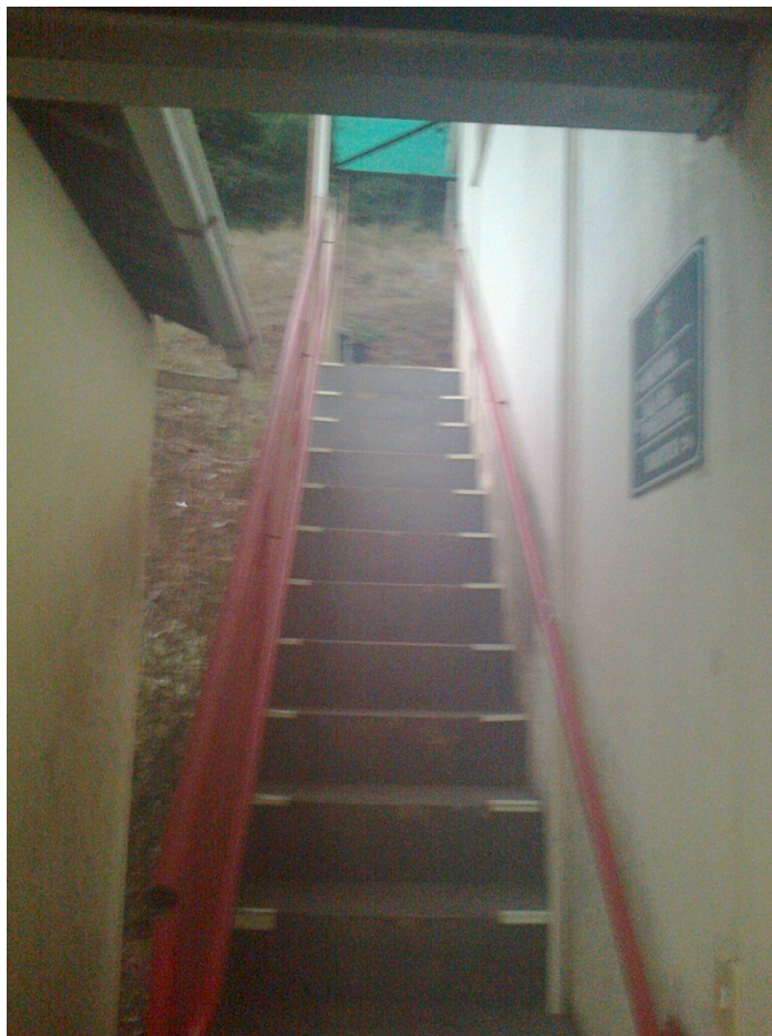
Foto 6 – Placa da escada, somente orientação, não tem informação em braile
