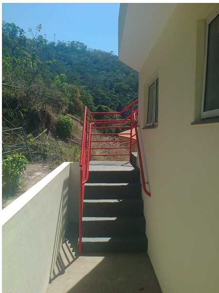
Foto 11 – Escada de acesso do 2º para o 3º pavimento
