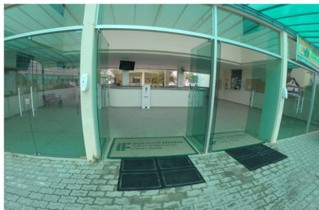
Imagem 12 – Portas de acesso a edificação não possuem sinalização, tapetes dificultam a circulação em rotas acessíveis. A edificação não possui mapa tátil de orientação.
