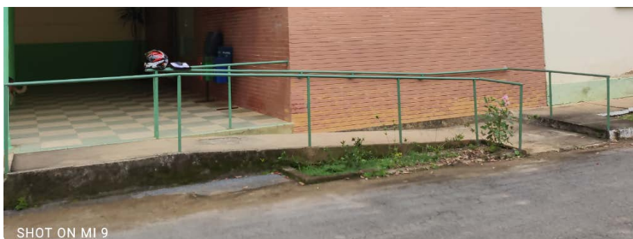
FOTO 3: Ausência de corrimão e guarda corpo na rampa.
