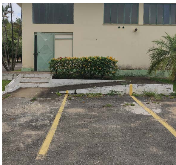
FOTO 3: Ausência de corrimão e guarda corpo na rampa.
