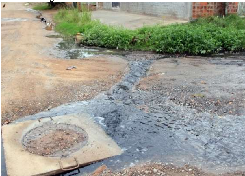
Figura 1 – Lançamento de esgoto in natura diretamente no solo em bairro de Santos Dumont, MG.
